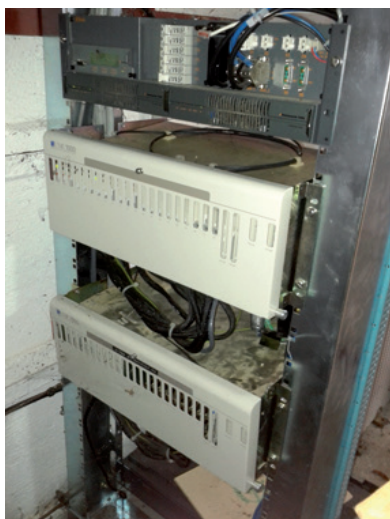
Figure 4.2 : exemple de multiplexage par GMUX
